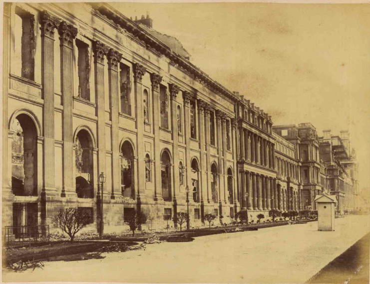
5. Palais des Tuileries, façade du côté du jardin.
